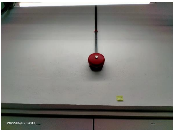
รูปที่ 3-53 อุปกรณ์ส่งสัญญาณ และแจ้งเหตุเพลิงไหม้
