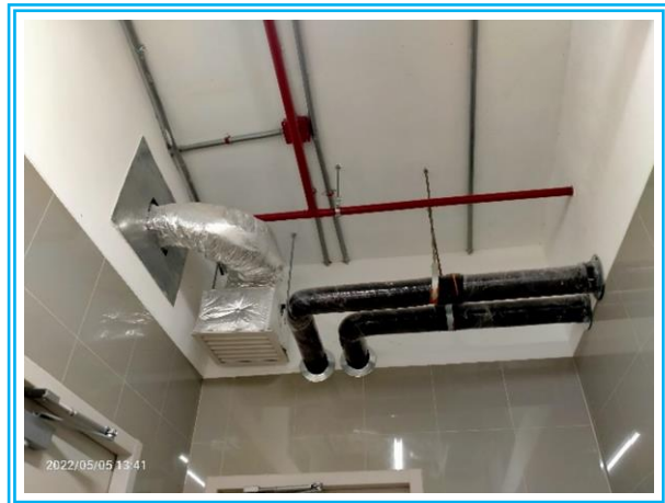
รูปที่ 3-31 ท่อพัดลมดูดอากาศประจำห้องพัสดุ
