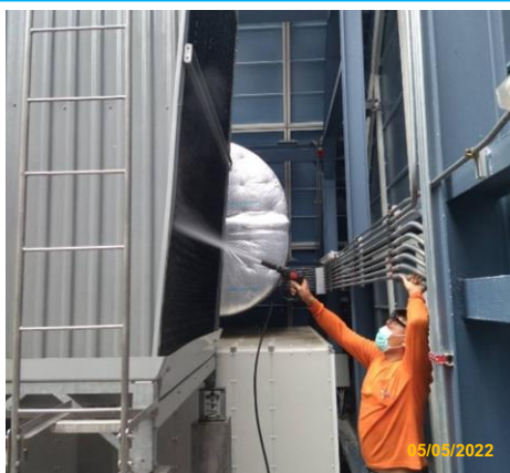
รูปที่ 3-7 การล้างทำความสะอาดห่อหุ้มเย็น
