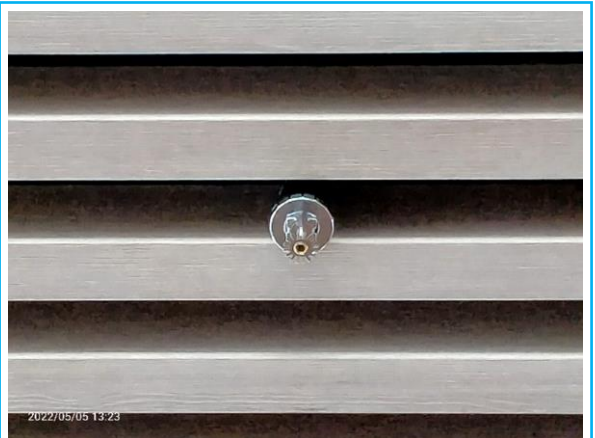
รูปที่ 3-55 หัวฉีดน้ำดับเพลิงอัตโนมัติ
