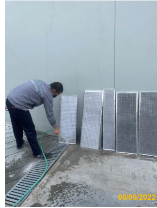
รูปที่ 3-5 การล้างทำความสะอาดเครื่องปรับอากาศ
